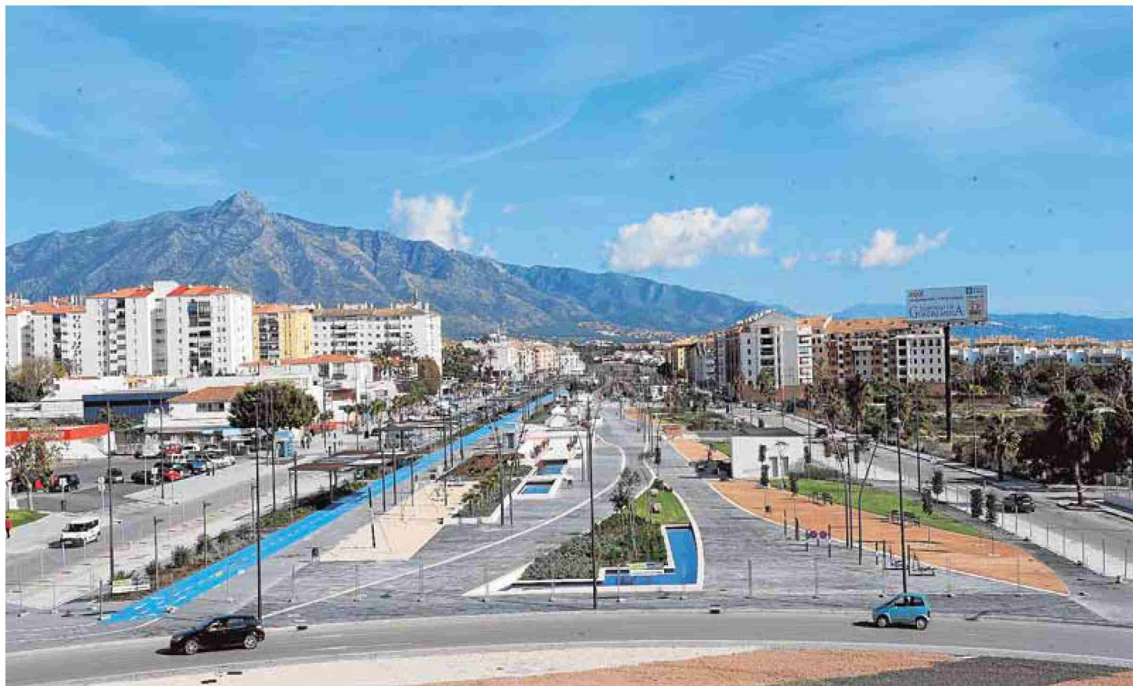
Vista general del estado en el que se encuentran las obras del parque bulevar. :: JOSELE-LANZA
