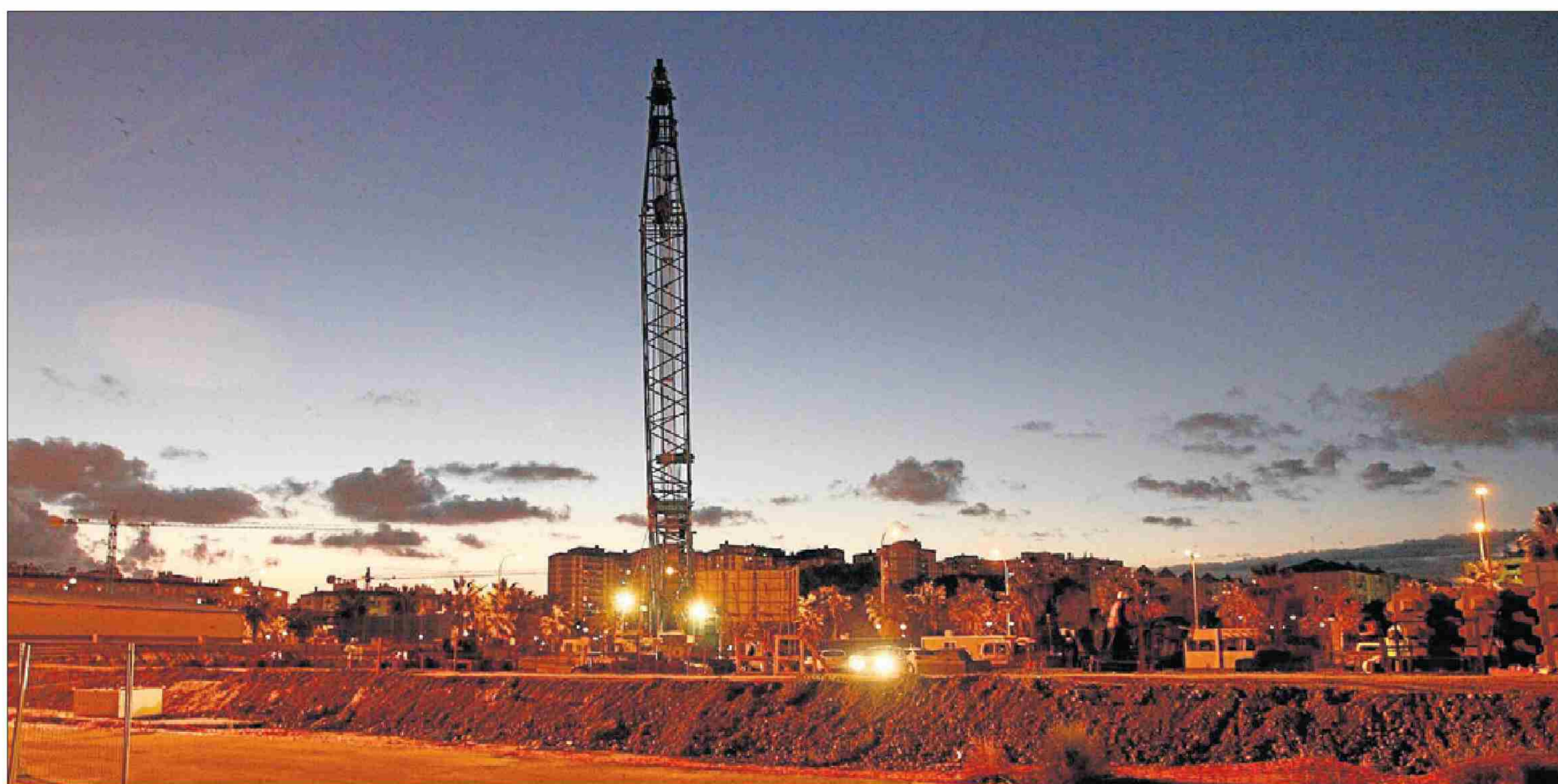
Vista de las obras que se están acometiendo en la plataforma de San Andrés para habilitar nuevos accesos. ARCINIEGA
