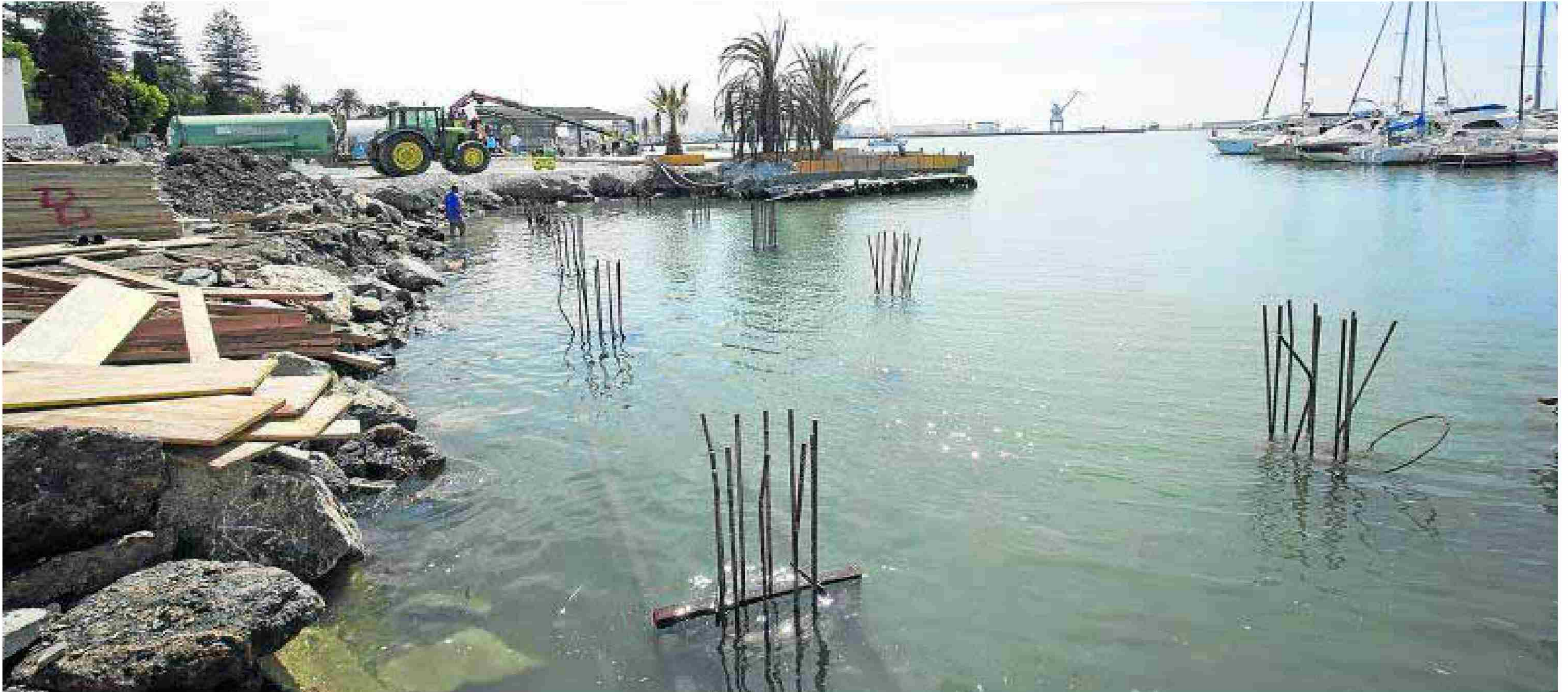
Obras de la marina seca dentro del puerto de Motril, frente al Club Náutico. :: SALVADOR RODRÍGUEZ
