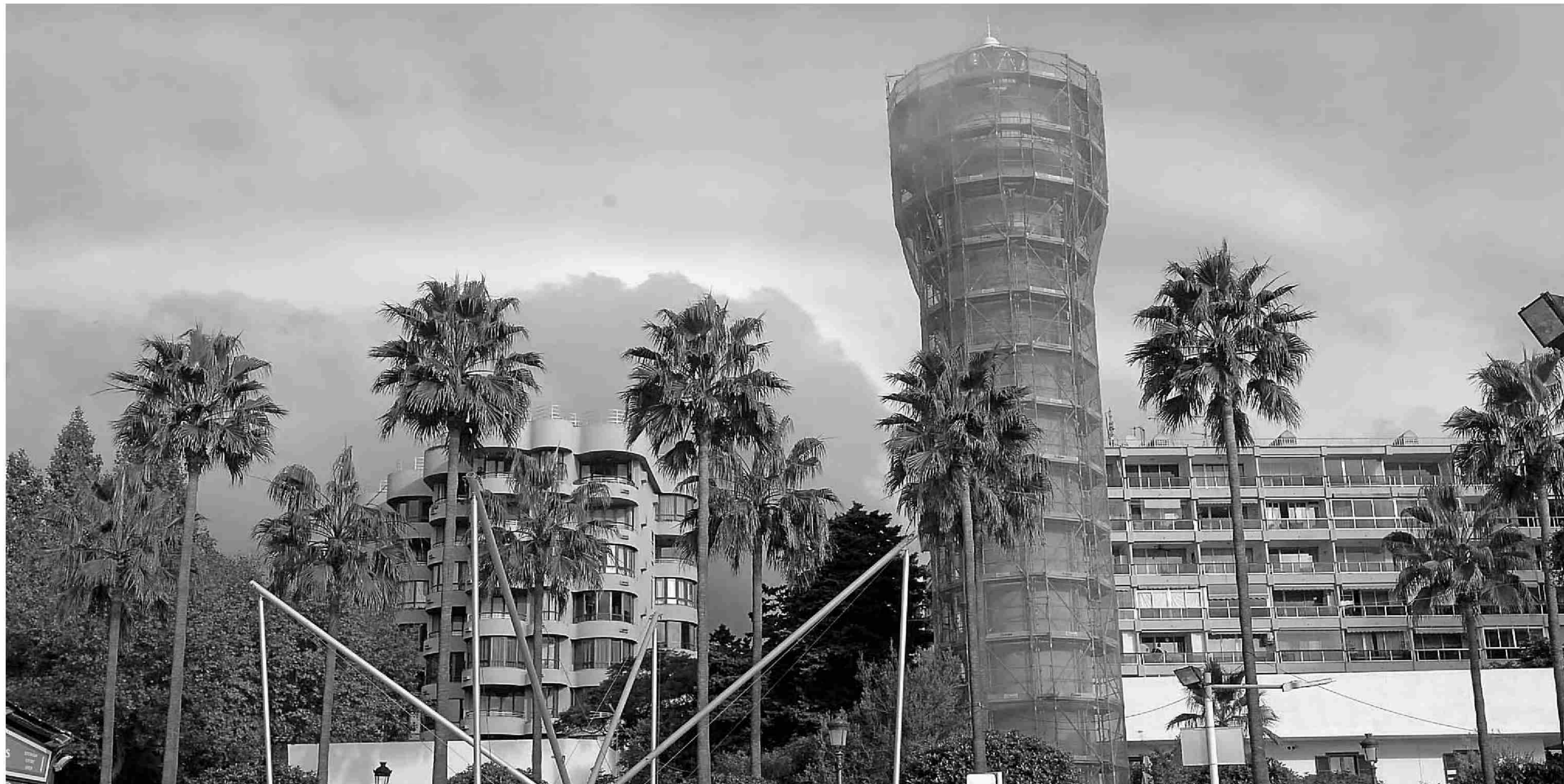
El faro, de 29 metros de altura, aparece estos días cubierto por andamios y telas metálicas para su reforma. :: JOSELE-LANZA
