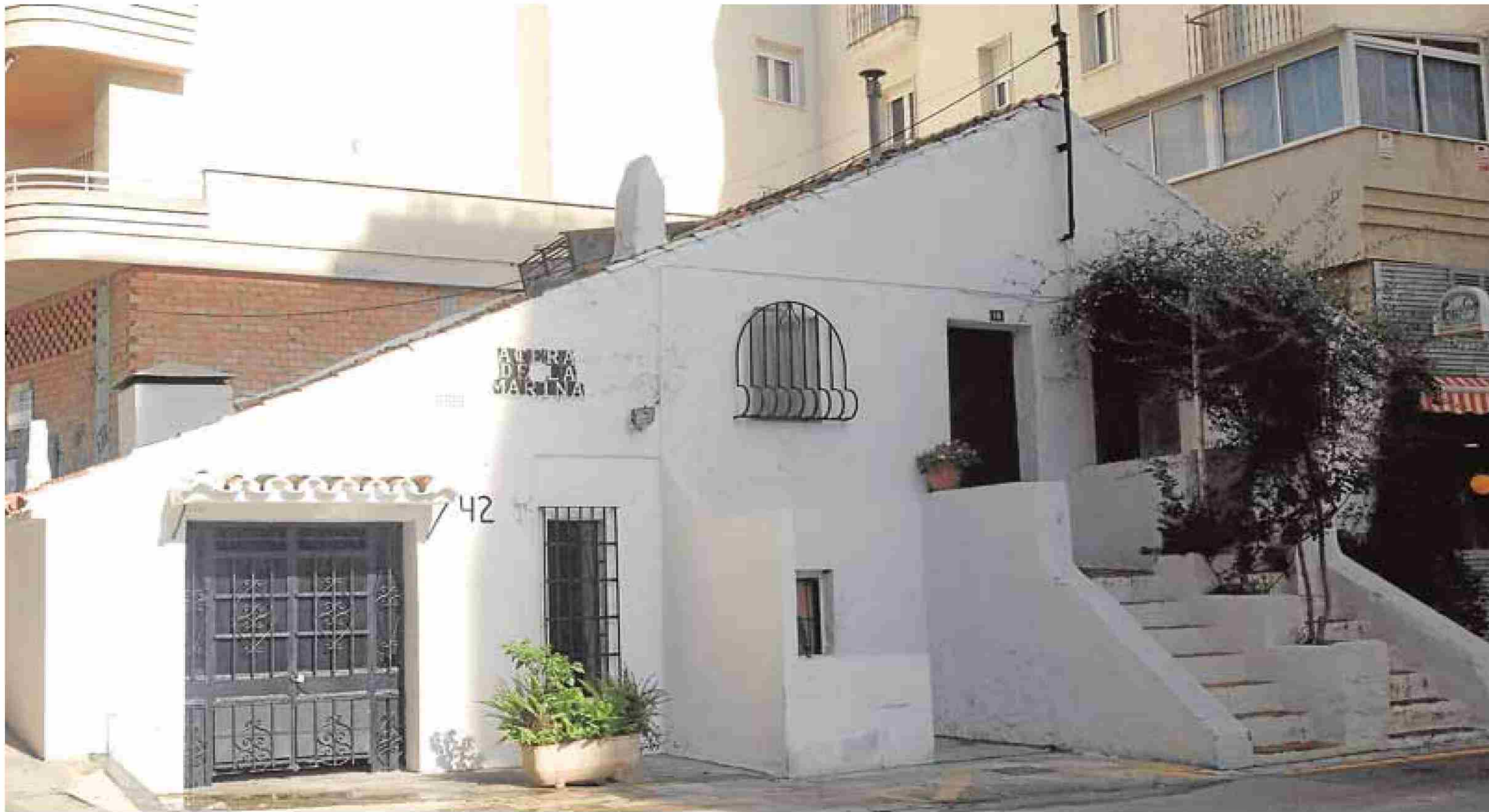
El proyecto contempla la expropiación de la casa que hace esquina entre la Acera de la Marina y José Vera. :: JOSELE-LANZA
