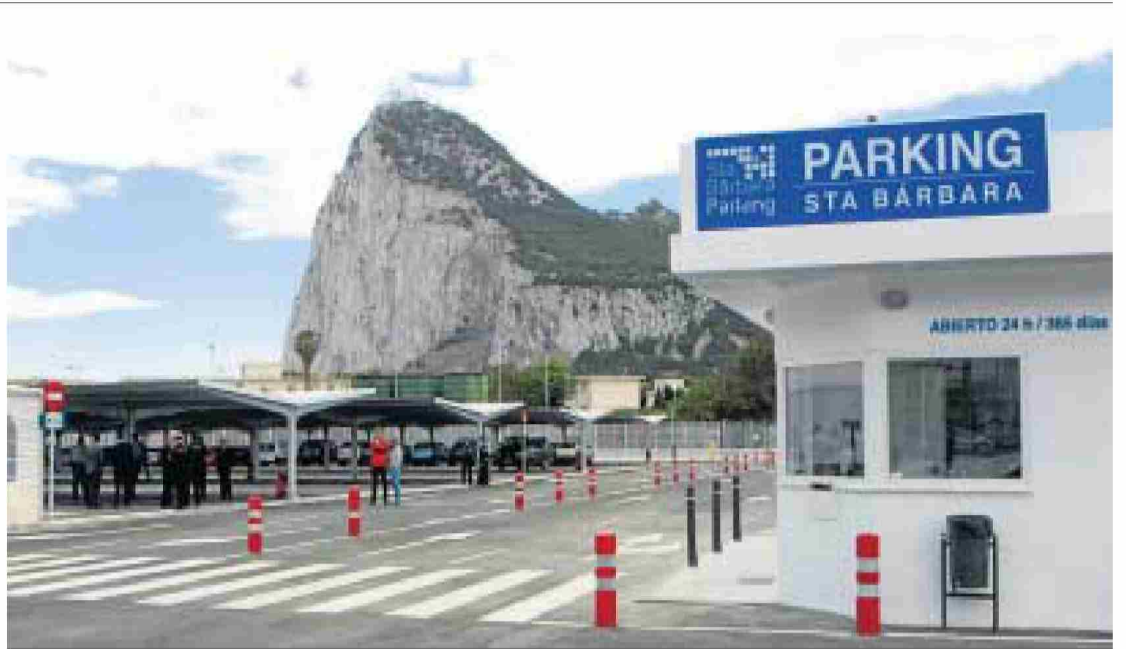
Imagen tomada desde el exterior del nuevo Parking de Santa Bárbara.
