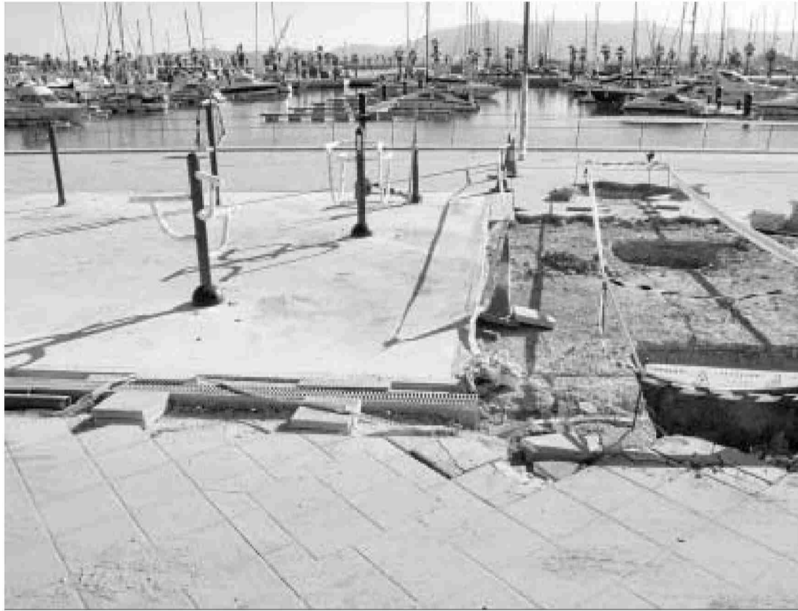
Imagen tomada ayer del estado de las obras.
