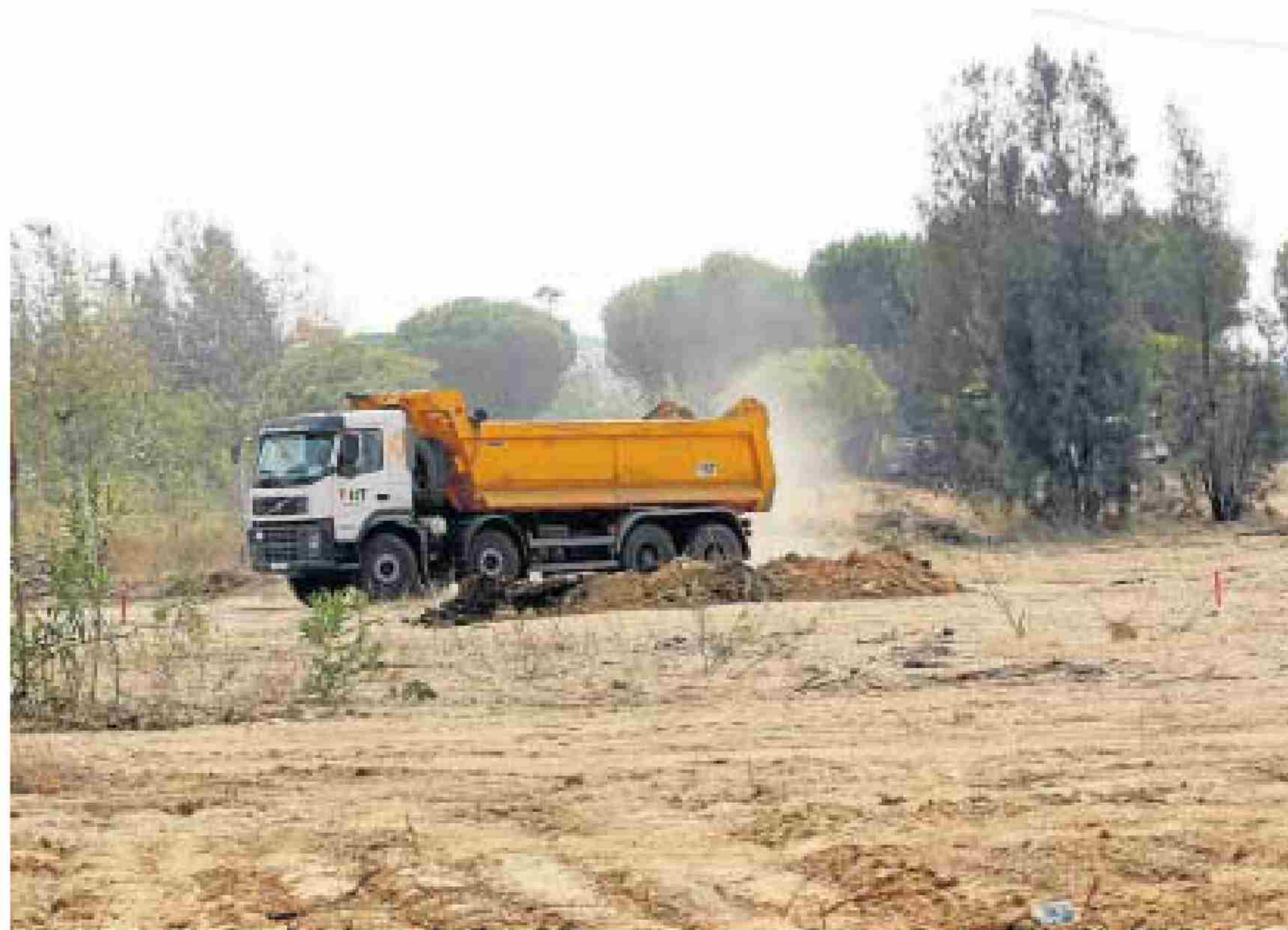
Un nuevo dispositivo de obras inició ayer los movimientos de tierra en el futuro Parque Sur.
