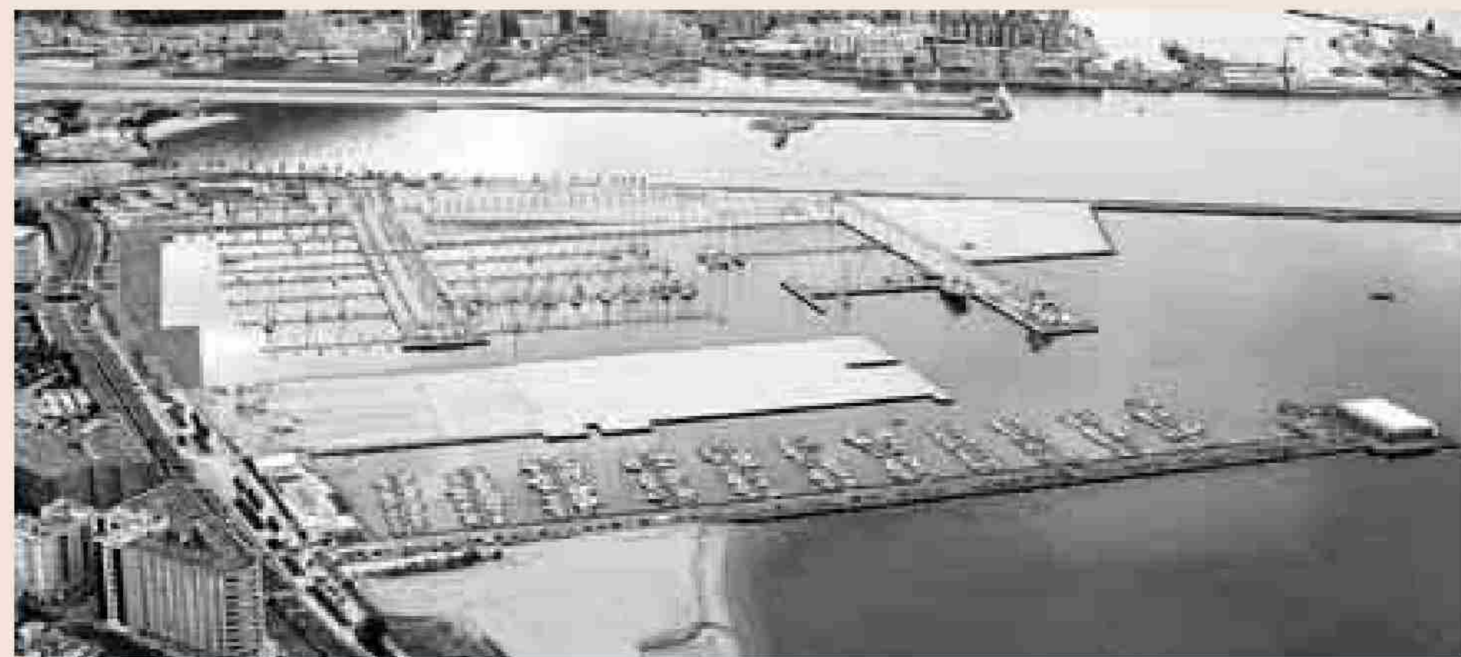
Recreación del aspecto que tendrá la zona tras las obras.
