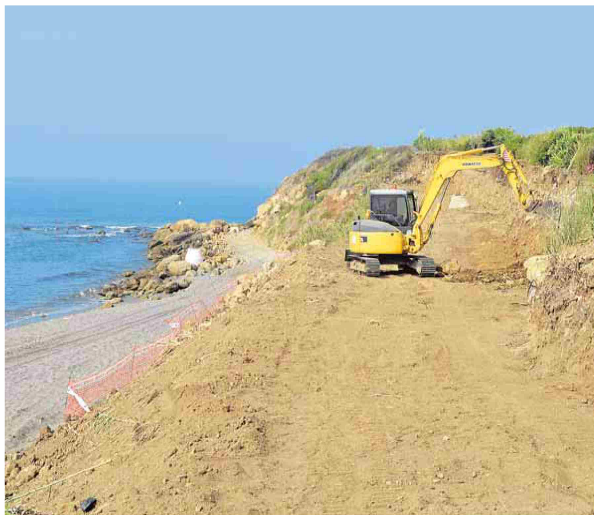
Comienzo de las obras para el primer pantalán de Estepona. :: L.P.
