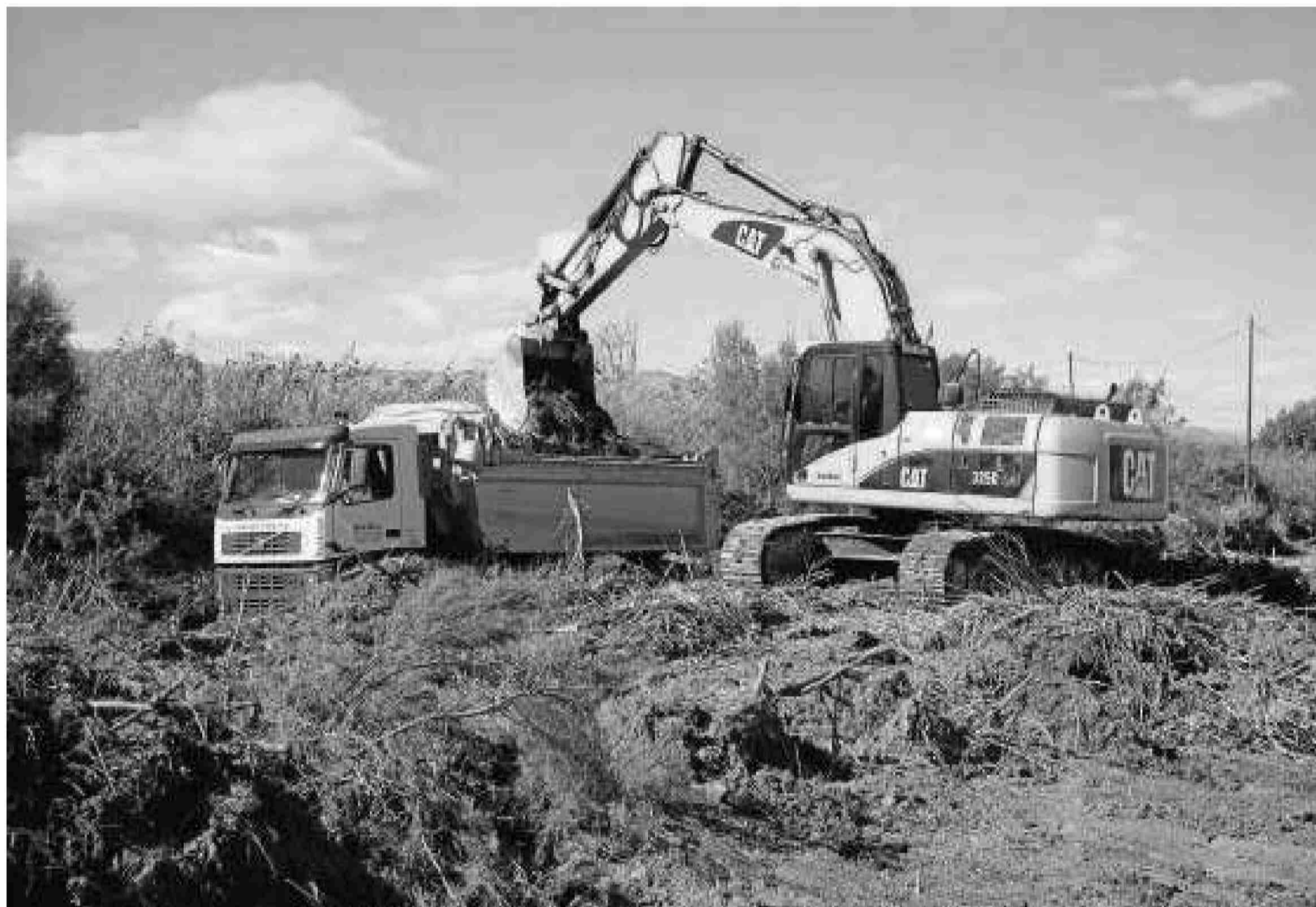
Las máquinas comenzaron ayer a desbrozar la rambla de El Charco de Costacabana.
